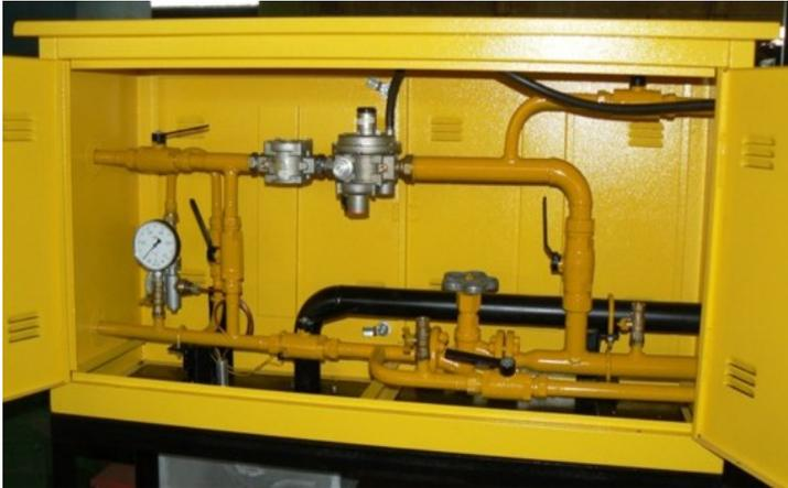
Данный газорегуляторный пункт шкафной выполнен на базе регулятора RG/2MB (Ду20) фирмы "MADAS" (Италия).
