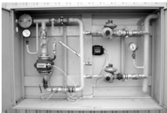
ШГРП выпускаются согласно ТУ с одной или двумя линиями редуцирования, в их состав могут входить фильтры, манометры и термометры. Для учёта газа используются соответствующие счётчики и, при необходимости, корректор расхода. Ящики окрашены в специальных камерах порошковой краской жёлтого цвета.
